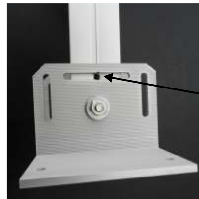
2º - FURAR O LOCAL DE FIXAÇÃO DO PARAFUSO TRAVANTE
